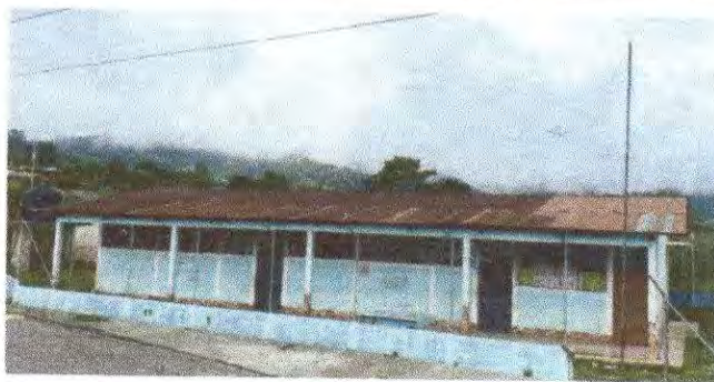
Foto1: Sustitución lamina, por lamina troquelada aluzinc calibre 26
