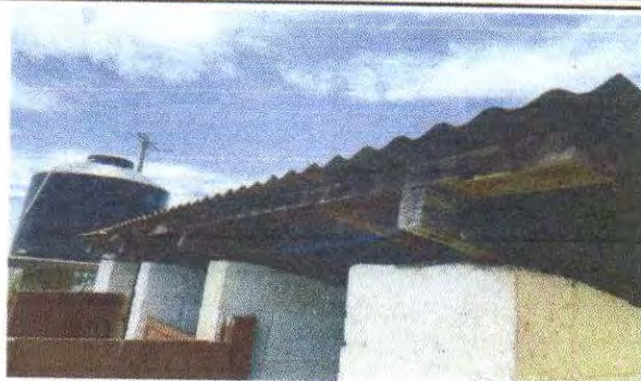
Foto 8: Sustrucción estructura de soporte de madera por metal (3x2 pulgadas)
