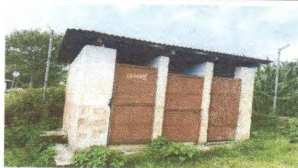
Foto 11: Sustrucción puertas en servicio sanitarios
