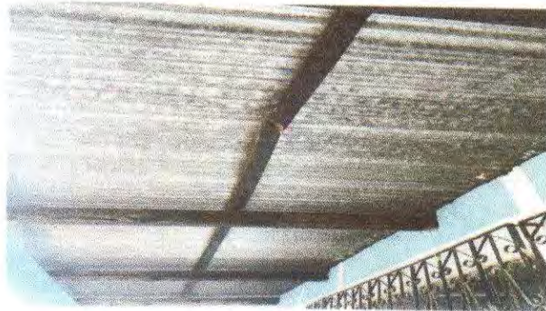
Foto2: Sustitución de estructura de soporte de madera por metal ( 3x2 pulgadas)
