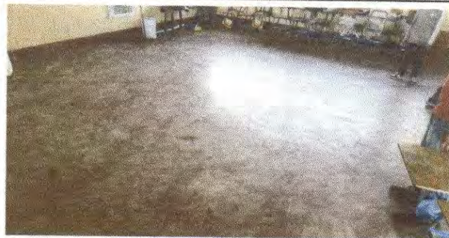
Foto 5: Sustitución piso de torta de cemento por piso cerámico
