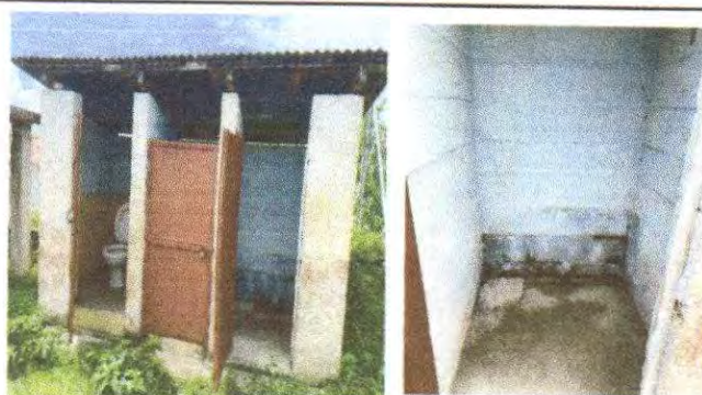
Foto 10: Sustrucción inodoro, Sustrucción Lavamanos
