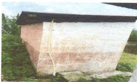
Foto 9: Repello en muro
