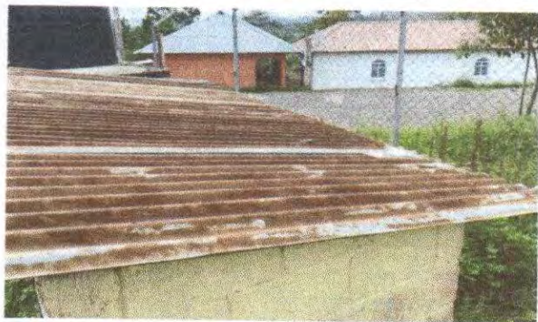
Foto 7: Sustrucción lamina, por lamina troquelada aluzinc calibre 26
